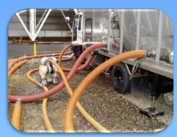
弊社の化学洗浄工事は、システム化学洗浄車に車載した洗浄設備により、**有機酸系洗浄剤**を使用して対象となる設備配管等に通液し、スケールを**溶解・除去**することができます。
